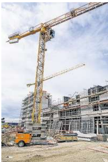
Das 25-Millionen-Euro-Projekt DV 7 nimmt Gestalt an.
