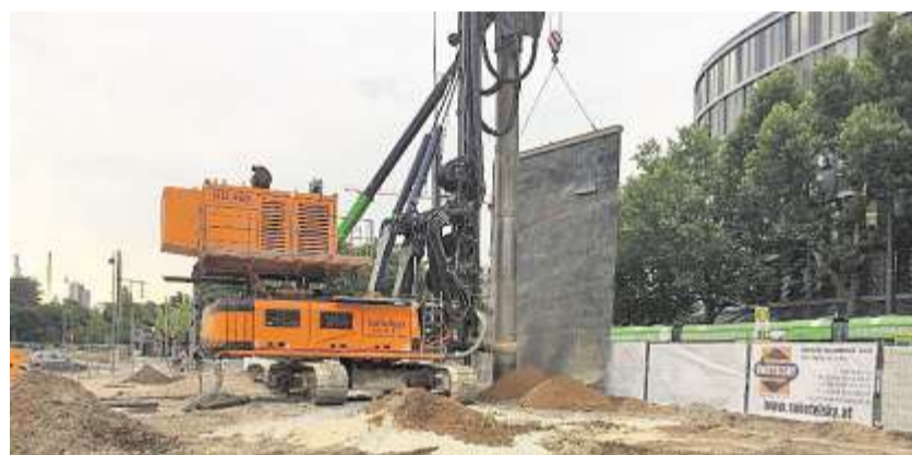
Die Firma Gollwitzer fertigt Baugruben, Pfahlwände und Verpressungen und sorgt für die Auftriebssicherung.
