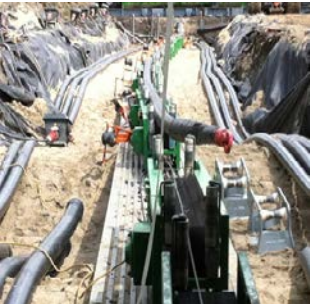
Unverbauter offener Graben
