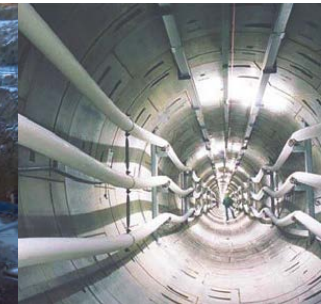
Leitungsgang in geschlossener Bauweise
