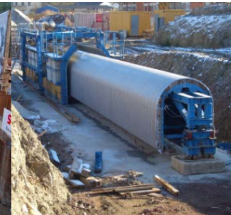
Leitungsgang in offener Bauweise
