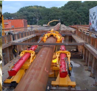
Rohre in geschlossener Bauweise
