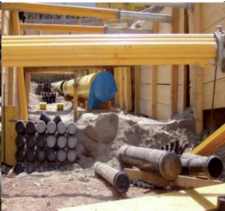
Verbauter offener Graben
