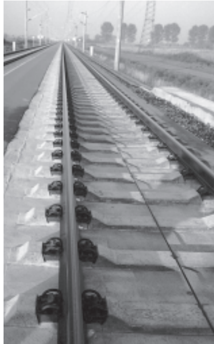
Abb. 1: Feste Fahrbahn, modifizierte Bauart Rheda auf der HGV Hannover-Berlin; Inbetriebnahme Herbst 1998
