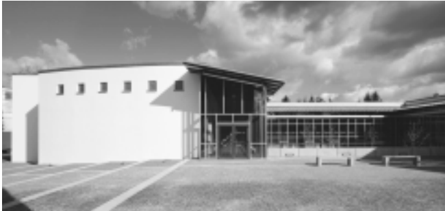
BauindustrieZentrum München-Stockdorf Tel.: 089/89 96 38 - 11
