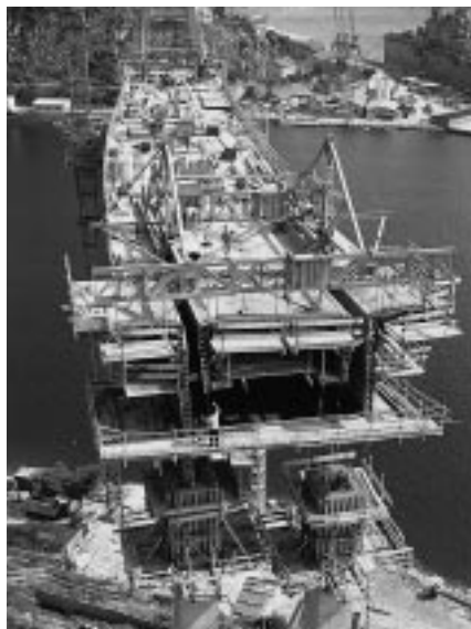
Brückenbau bei Dubrovnik Foto: Walter Bau-AG
