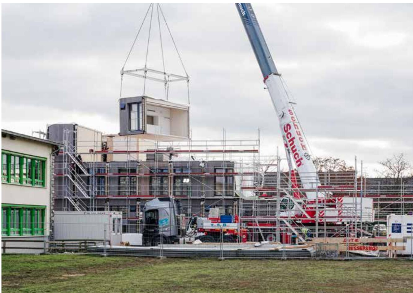
Montage der hochvorgefertigten Module in kürzester Bauzeit vor Ort
