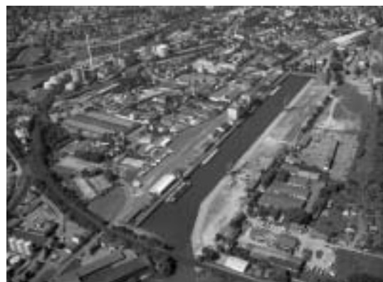
Infrastruktur zahlt sich aus: Ein zentraler Schlüssel für den Erfolg der Wirtschaftsregion Regensburg ist die hervorragende Verkehrsanbindung. Das Güterverkehrs- zentrum Regensburg und der Regensburger Hafen zeigen, worauf es ankommt: optimale Schnittstellen zwischen den Nah- und Fernverkehrsträgern Straße, Schiene, Schiff.
