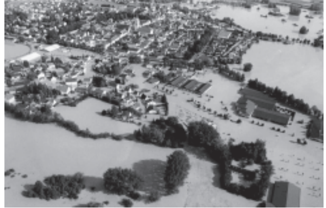
In Neustadt a.d. Donau wurde beim Pfingsthochwasser 1999 nach dem Deichbruch das gesamte Poldergebiet bis zu 2 m hoch überflutet. Wo die Grenzen des technisch Machbaren erreicht sind, helfen weitergehende Versorgungsmaßnahmen zur Begrenzung der Schäden. Foto: FFW Neustadt/Donau
