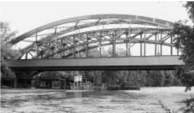
Neubau der Lechbrücke in Augsburg
