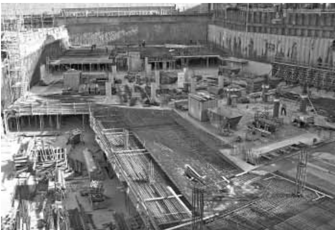
Blick auf die Baustelle Angerhof in München
