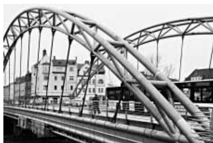
Der Neubau der Luitpoldbrücke
