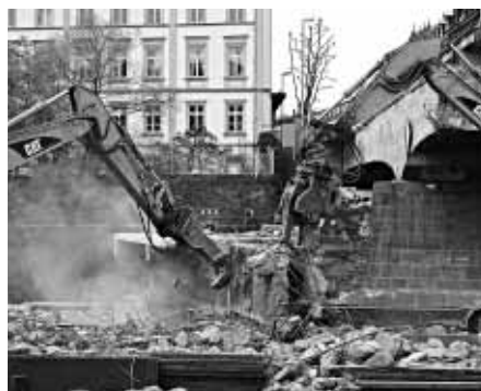
Abbruch der Luitpoldbrücke
