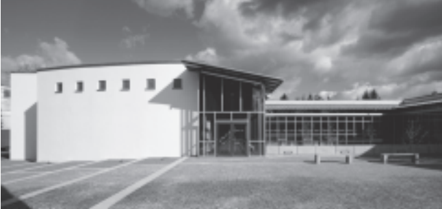
BauindustrieZentrum München-Stockdorf Tel.: 089/89 96 38-11
