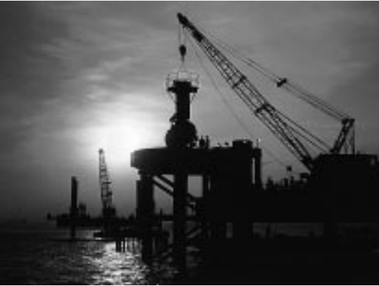
Abwasserkanal Mumbai (Bombay)/Indien
