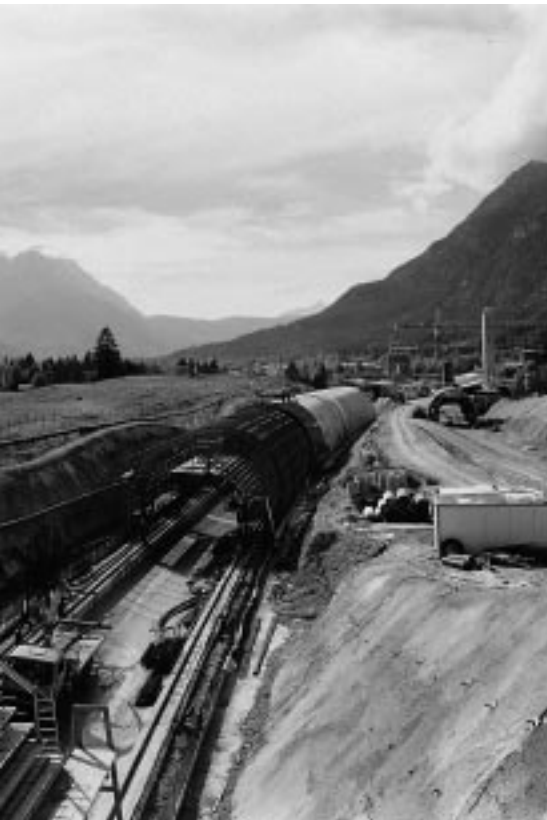
Privat vorfinanzierter Autobahntunnel Farchant (A 95 München-Garmisch)
