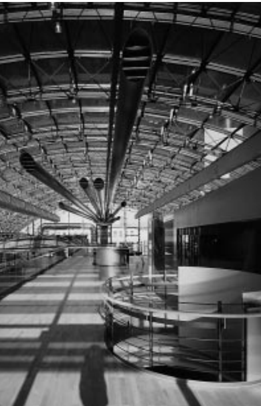
Technisches Zentrum der Landeszentralbank Bayern, München
