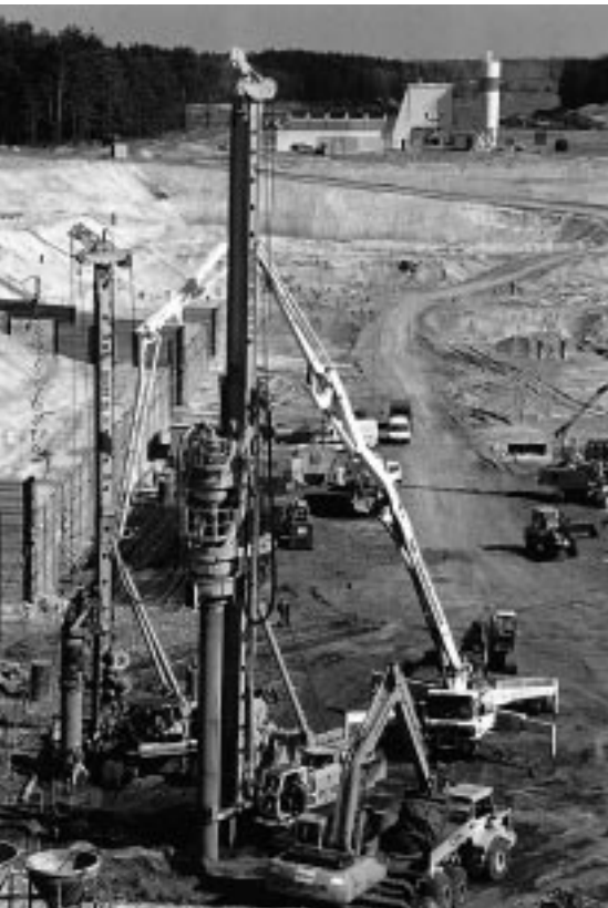
Schleuse Hohenwarthe bei Magdeburg
