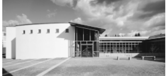
BauindustrieZentrum München-Stockdorf Tel.: 089/89 96 38 – 11
