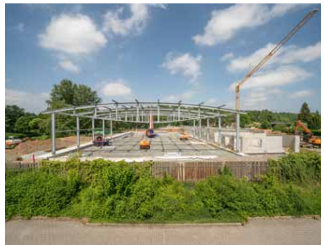
Eislauf- und Rollschuhbahn, Stadt Hof
