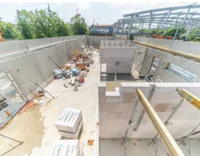
Eislauf- und Rollschuhbahn, Stadt Hof
