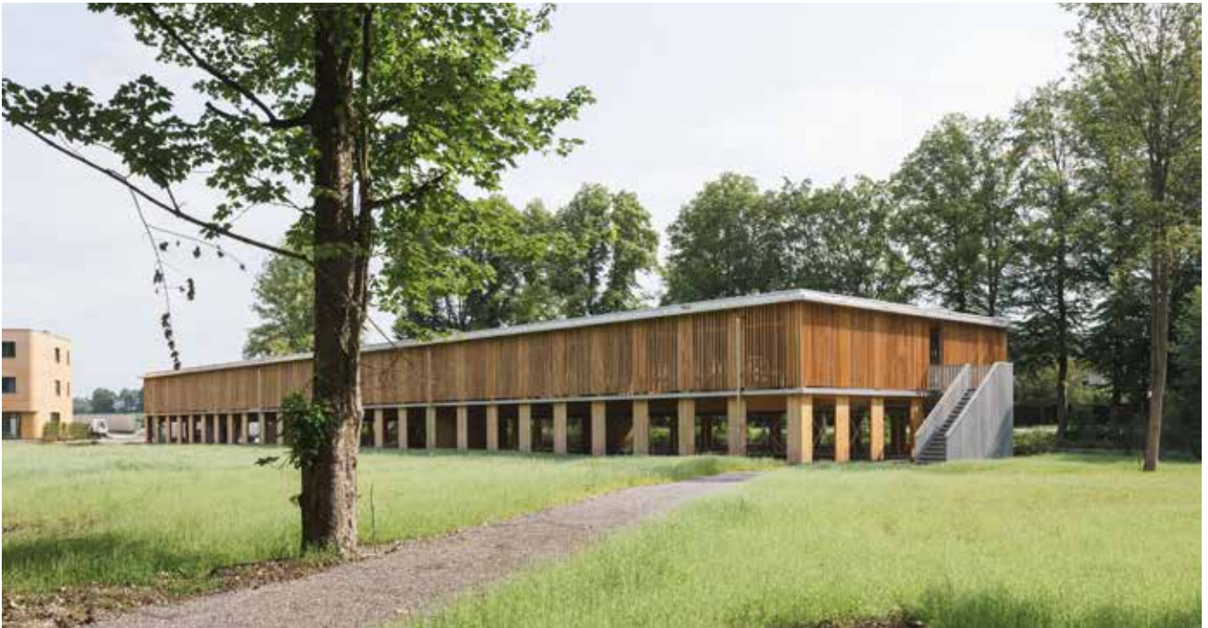
Das neuartige Parkdeck aus Holz, Bad Aibling
