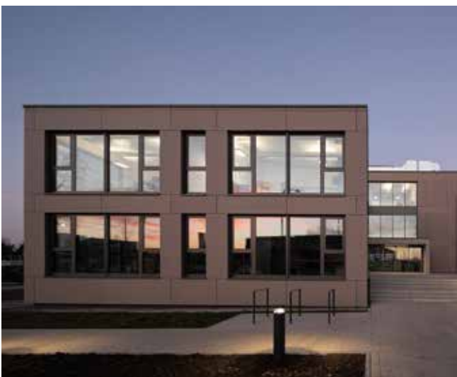
Neubau ZÜBLIN-Direktion Ulm, Neu-Ulm
