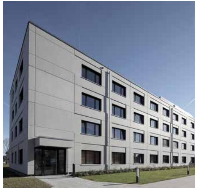
Unterkunfts- und Lehrsaalgebäude V. Bereitschaftspolizei, Königsbrunn
