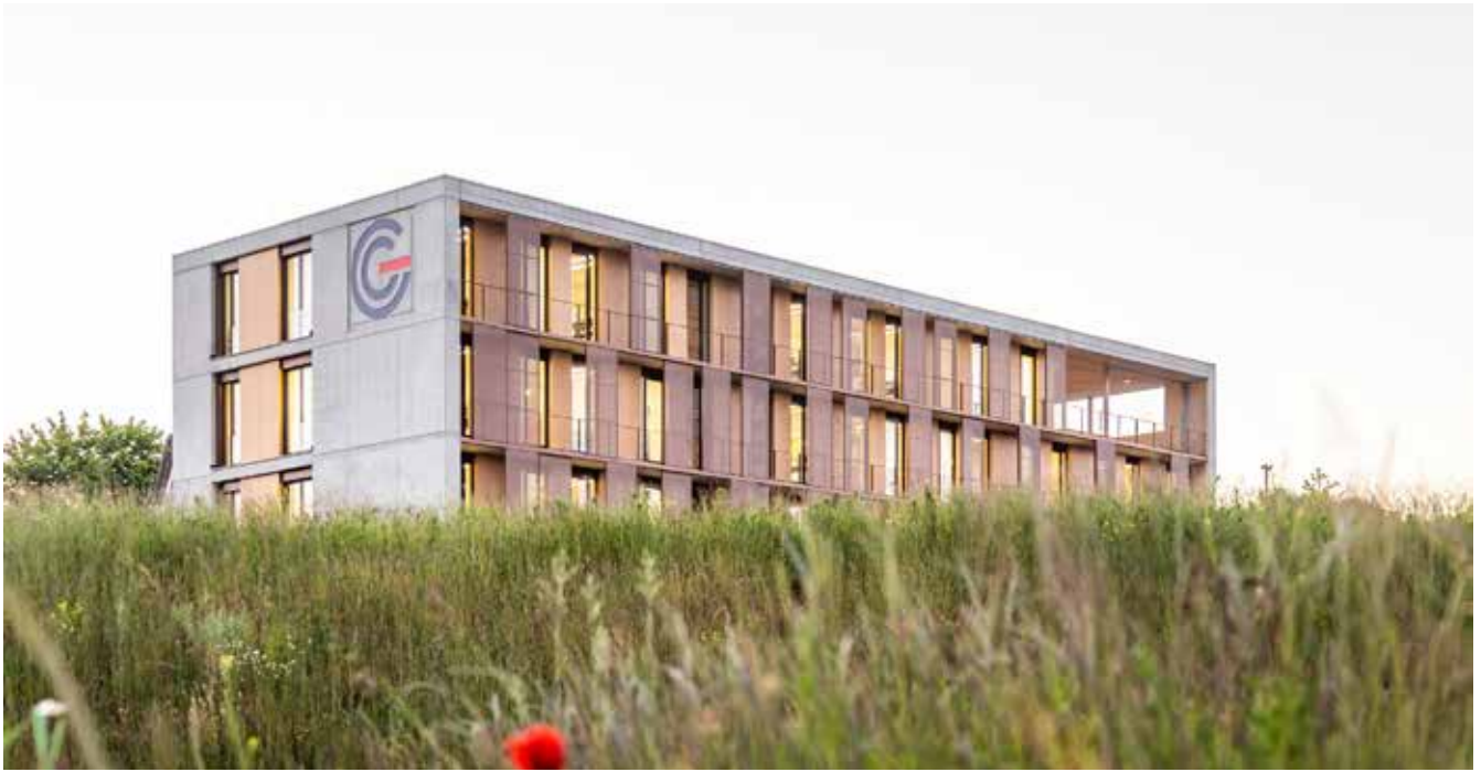
Verwaltungsbäude der Firmengruppe Göbel, Rimpfing
