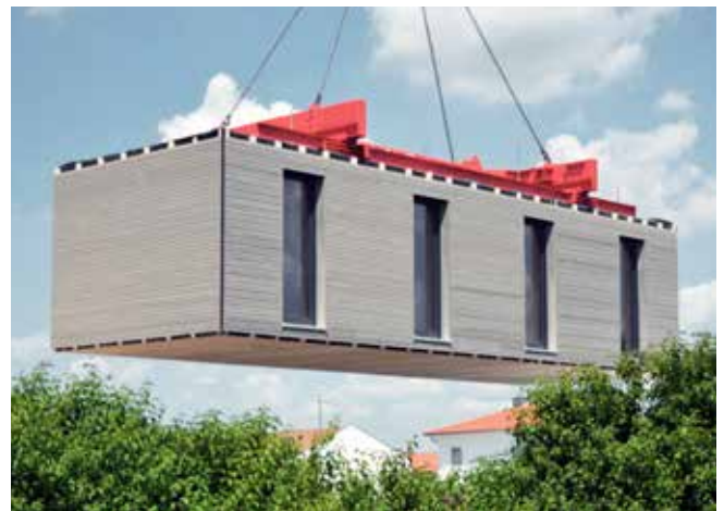
Aufstellung eines Holzmoduls
