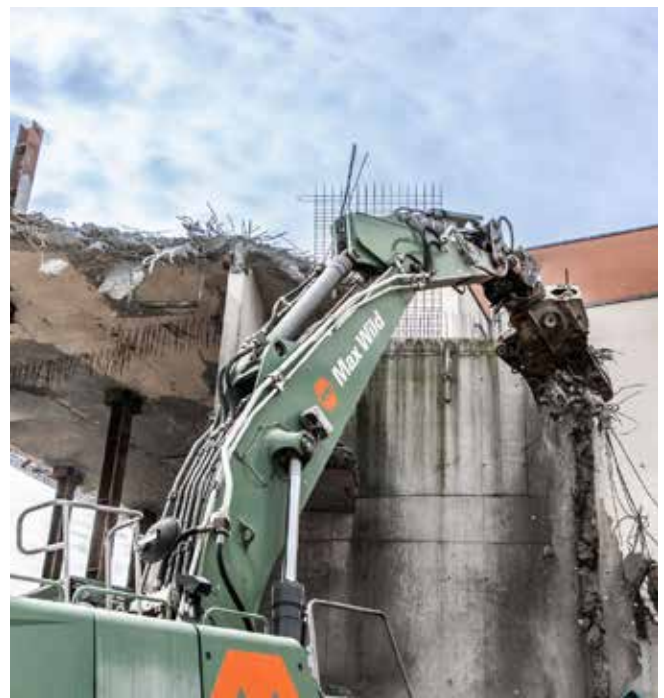
Abbruch von Industriegebäuden
