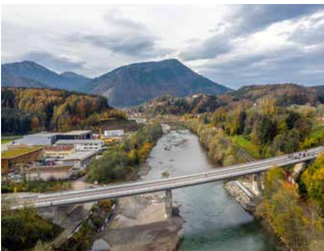
Brücke , Stein Immenstadt
