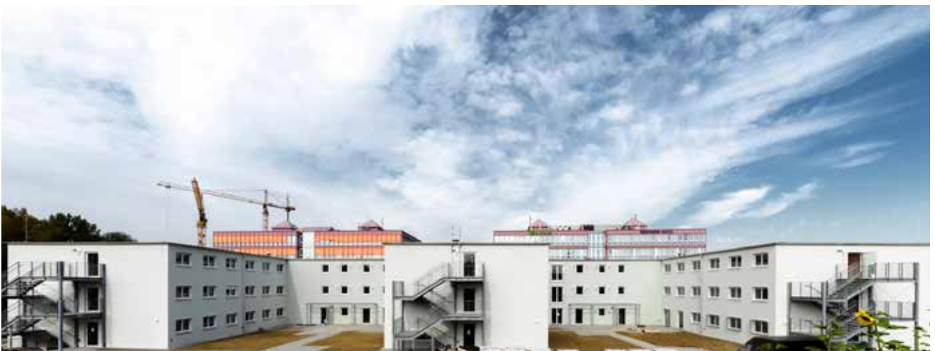
Temporäres Wohnen Kronstadter Straße, München
