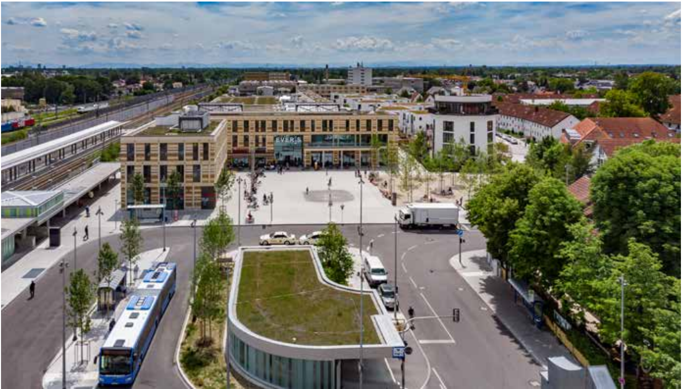
Einkaufszentrum mit Tiefgarage sowie Geschäftshaus mit P+R-Anlage inkl. Vorplatzgestaltung, Oertelplatz München
