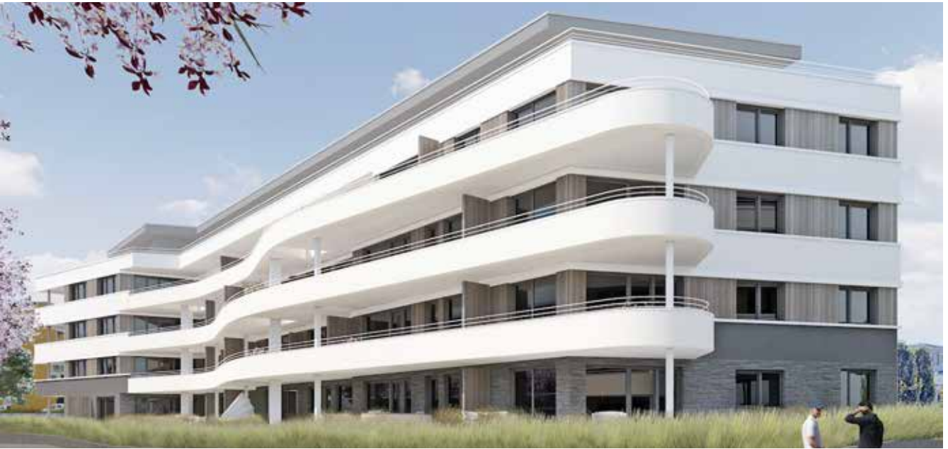
Häuser im Park, Ostfildern
