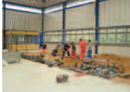
Rohrleitungs- und Kanalbauarbeiten in der neuen Multifunktionshalle
