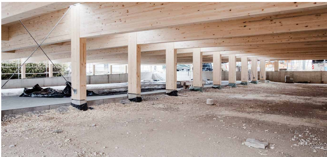
Die Arbeiten am neuen Parkdeck gehen gut voran
