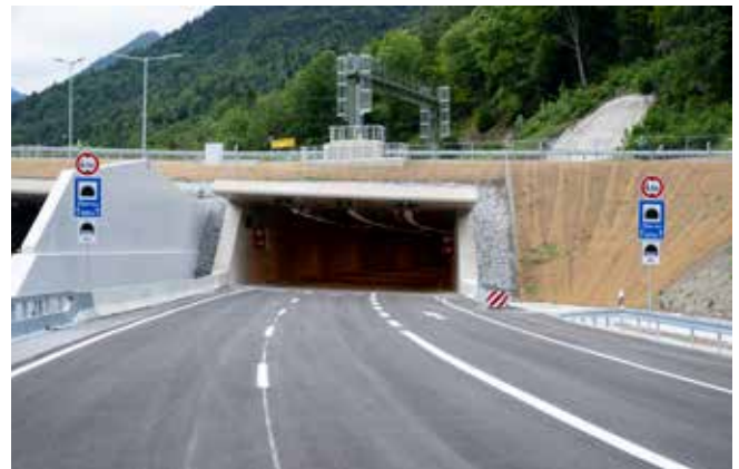
Nach elfjähriger Bauzeit wird an der viel befahrenen Bundesstraße 2 nach Garmisch-Partenkirchen die Umgehung samt Tunnel eröffnet.
