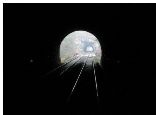
Die Tunnel im Pegnitztal sind zu klein für modernen Güterverkehr
